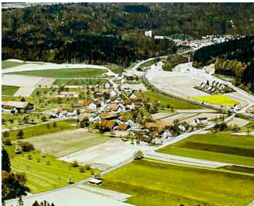
Luftaufnahme von Dättwil aus dem Jahr 1967: Erste Vorarbeiten zum Baregg Tunnel sind erkennbar BILD: ZVG | ETH ZÜRICH
