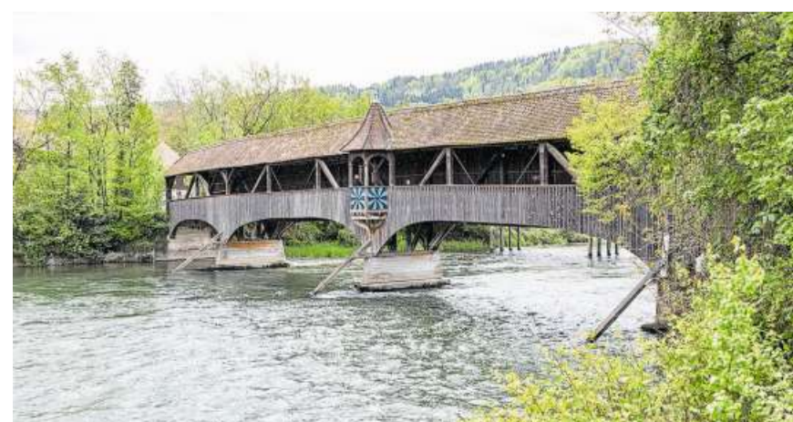
Die Holzbrücke über die Limmat verbindet Turgi mit dem ABB-Areal.
