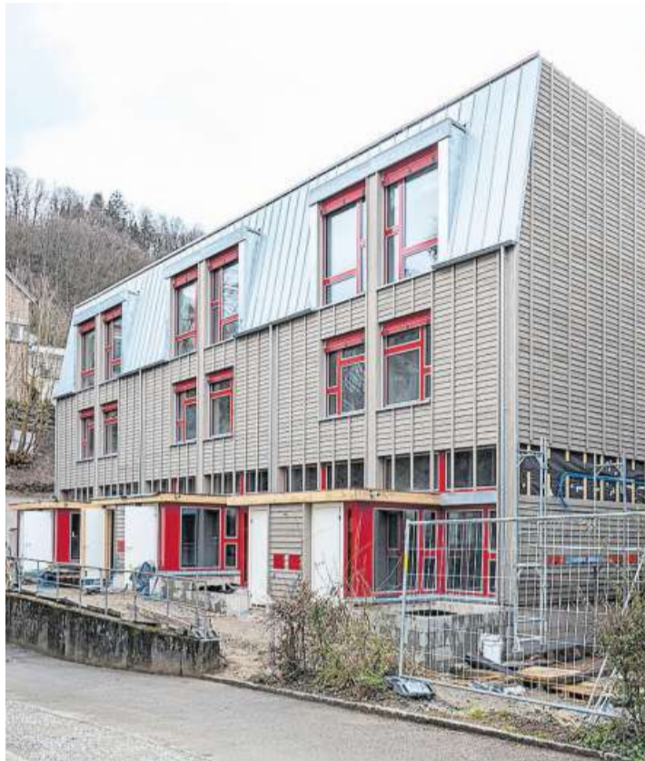
Bei einem der zwei Reihenhausbaukörper sind die Gerüste bereits entfernt worden. Bild: Mathias Förster
