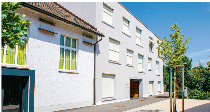
Der Anbau beim Schulhaus Neumatt 2 an die Halle Träff wurde 424 000 Franken teurer als geplant
